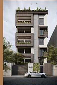
پروژه کلارآباد سال ۱۳۹۸
