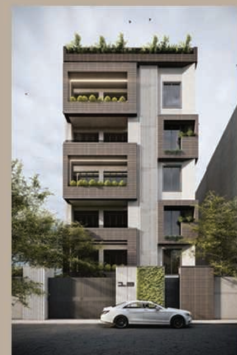
پروژه کلارآباد سال ۱۳۹۸
